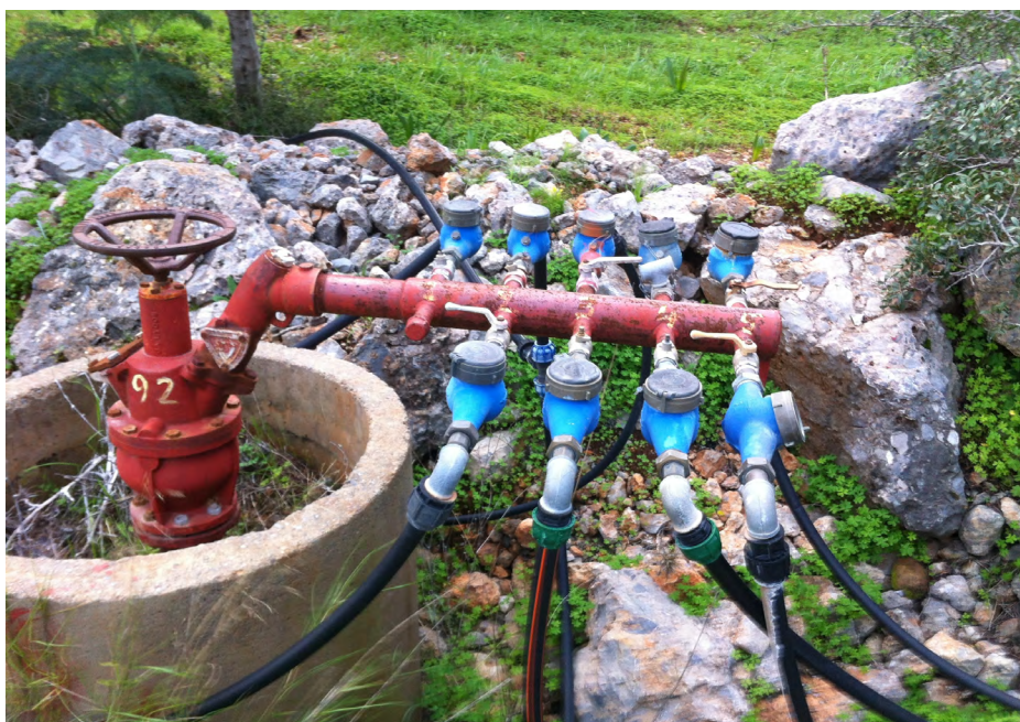
Εικόνα 1. Υδροληψία με 9 υδροστόμια στην Κρήτη
