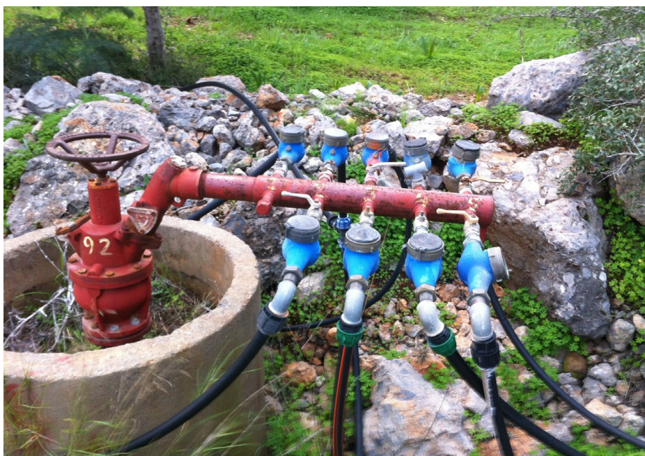
Εικόνα 1. Υδροληψία με 9 υδροστόμια στην Κρήτη
